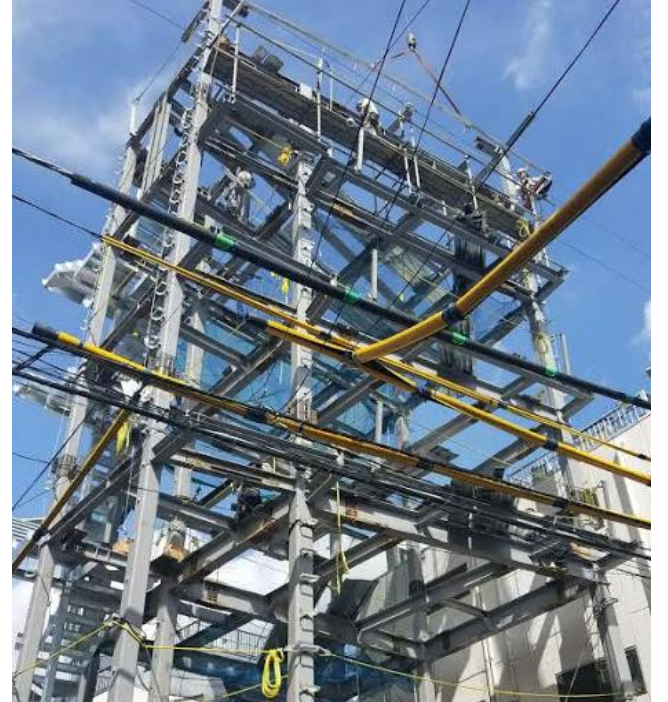
北千住マンション新築工事
